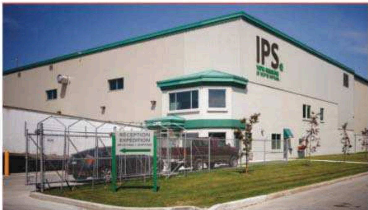
En décembre dernier, Raed Béchara et son équipe ont démonté les équipements et la marchandise dans cette usine située sur la rue de Lière à Lével. Un défi de taille qui a été relevé par tous les employés.
